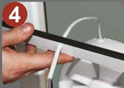
В заранее подготовленное отверстие в штапике ( $\varnothing$  6 мм) вставляется провод электропитания вентилятора.
