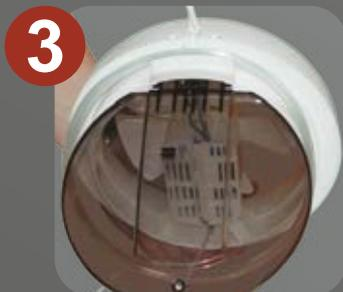
В подготовленное отверстие вставляется вентилятор (защитный клапан должен быть открыт). Сначала вставляется верхний край, который упорной планкой прижимается к кромке оконного полотна, затем нижний край.
